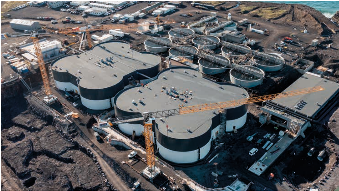
■ Frá framkvæmdasvæði First Water í Þorlákshöfn. Hér sést umfangið vel.
