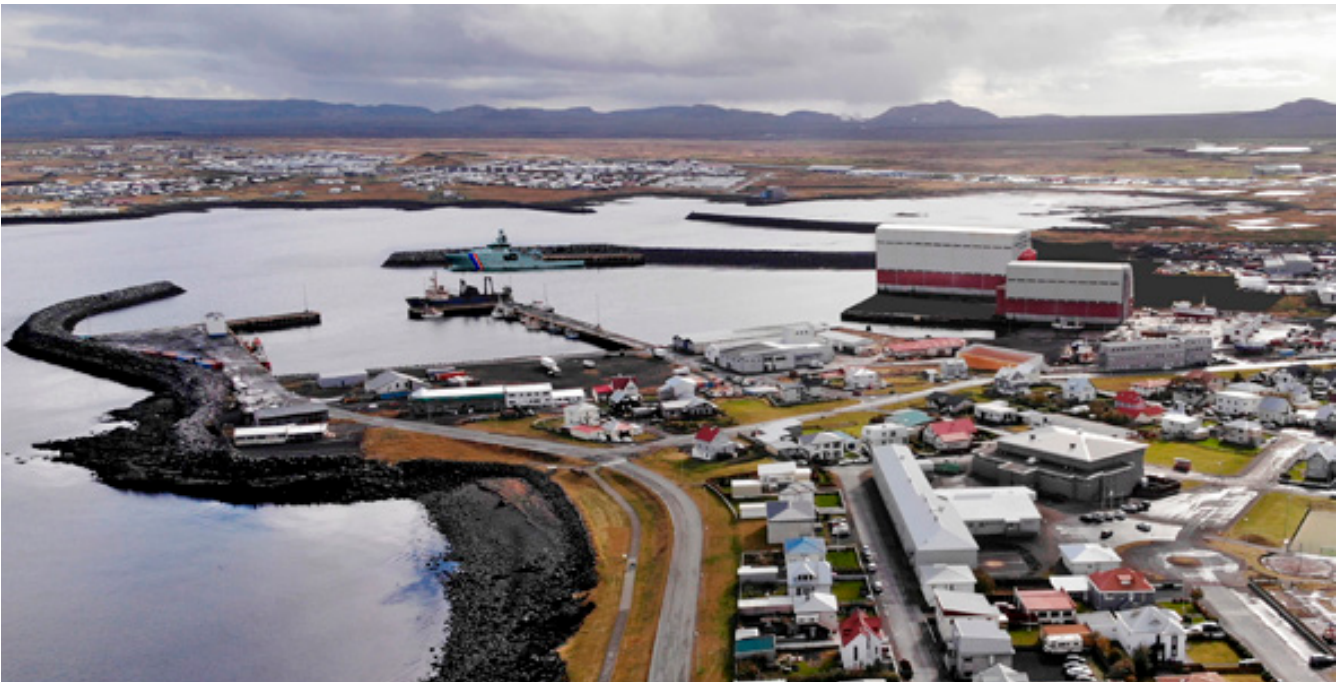
■ Séð yfir fyrirhugað athafnasvæði Skipasmiðastöðvar Njarðvíkur og Landhelgisgæslunnar. Inn á þessa mynd er búið að setja nýtt og stærra málningarhús og garðurinn fyrir Gæsluna og nýr kantur kominn inn á myndina. Þessi aðstaða verður mikil bylt- ing í þjónustu við allar stærðir af íslenskum fiskiskipum.
