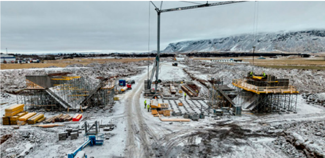
■ Austan Selfoss er unnið að byggingu brúar sem reist verður yfir nýjan hluta Hringvegjar. Vegtenging verður þaðan annars vegar að hringtorginu austan við Selfoss og hins vegar að golfvelli Selfoss og Laugardælum norðan við Hringveg.
