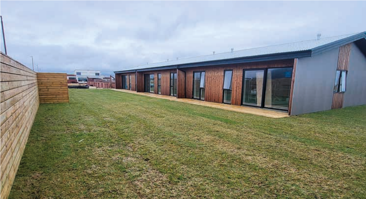
■ Fallett raðhús við Vetrarbraut í Þorlákshöfn, reist með Durisol byggingarsteinum.
