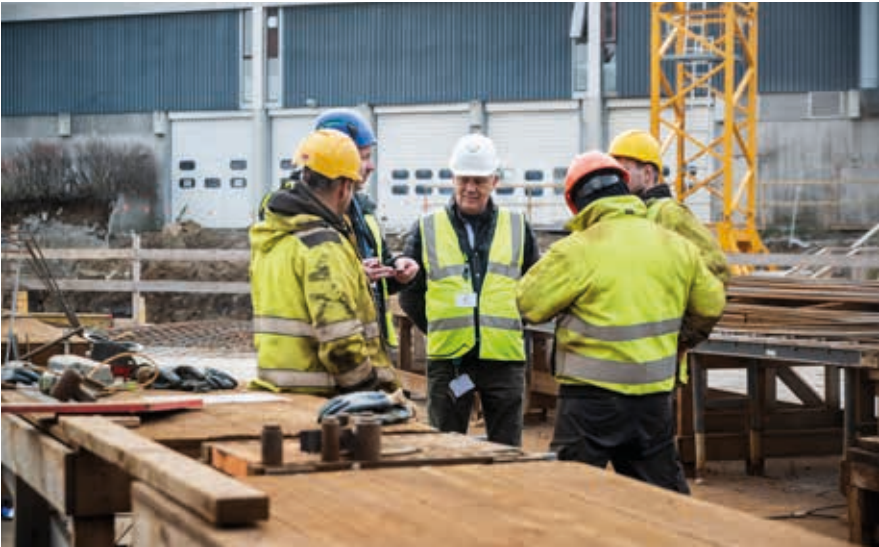
■ Jón Bjarni heilsar upp á félagsmenn í heimsókn á byggingarstað.
