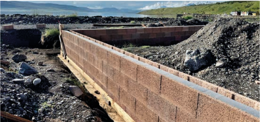
■ Durisol fæst í mörgum gerðum; sem útveggir, innveggir, eldvarnaveggir eða sökkulveggir, líkt og ér er í byggingu á Hjalteyri við Eyjafjörð.
