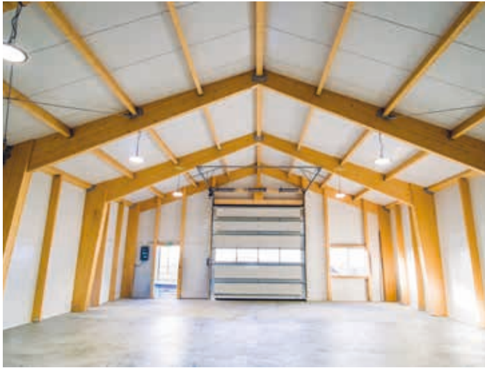
■ Steinullareiningarnar og grind úr límtré gera byggingarferlið auðveldara og henta vel í stærri og smærri verkefni.
