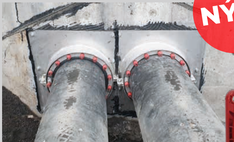
VERK UNNIÐ Á ÍSLANDI INNTAKSPÉTTI OPIN OG SETT EFTIRÁ
