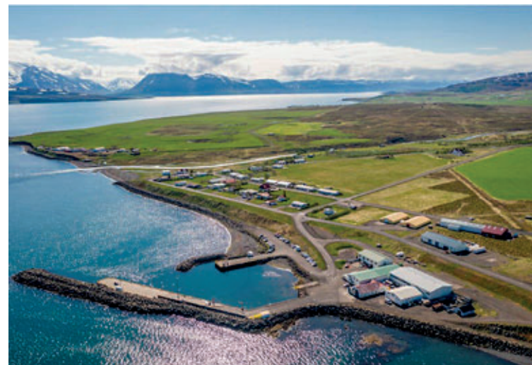
■ Árskógsshöfn er tengihöfn Hríseyjarferjunnar Sævars. Þörf er á að hækka grjótgarða í báðum höfnunum á Árskogsströnd.
