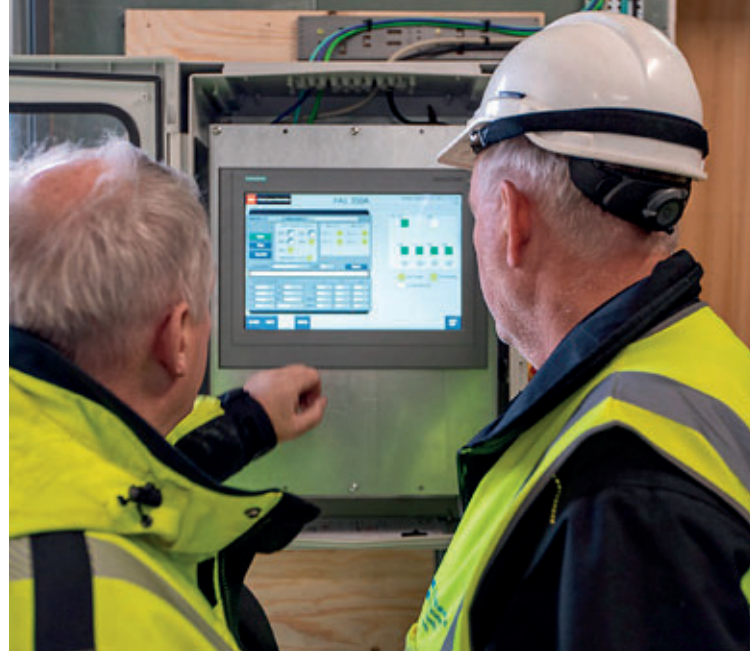
■ Fjölbættir möguleikar eru í því rafmagn sem í boði er í landtengingunni á Faxagarði, þ.e. mismunandi spenna og tíðni.
