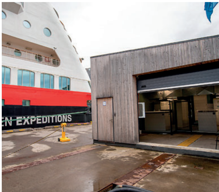
■ Þjónustuhús fyrir landtenginguna á Faxagarði. Batterið Arkitektar hannaði húsið en Verkís sá um verkfræðihönnun þess.
