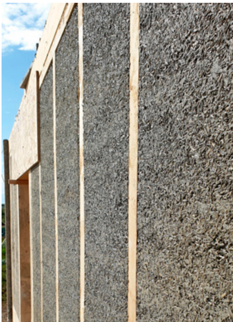
■ Askur styrkti þróunarverkefnið Biobuilding þar sem hampur, ræktaður á Íslandi, er notaður sem byggingarefni í hús. Hér er útveggur úr íslenskum hampi.
