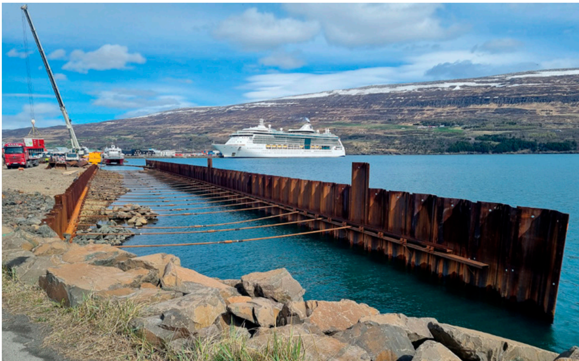
■ Stálpil frá GA Smíðajárni í nýrri Torfunefsbyggju á Akureyri en þær framkvæmdir standa nú yfir.
