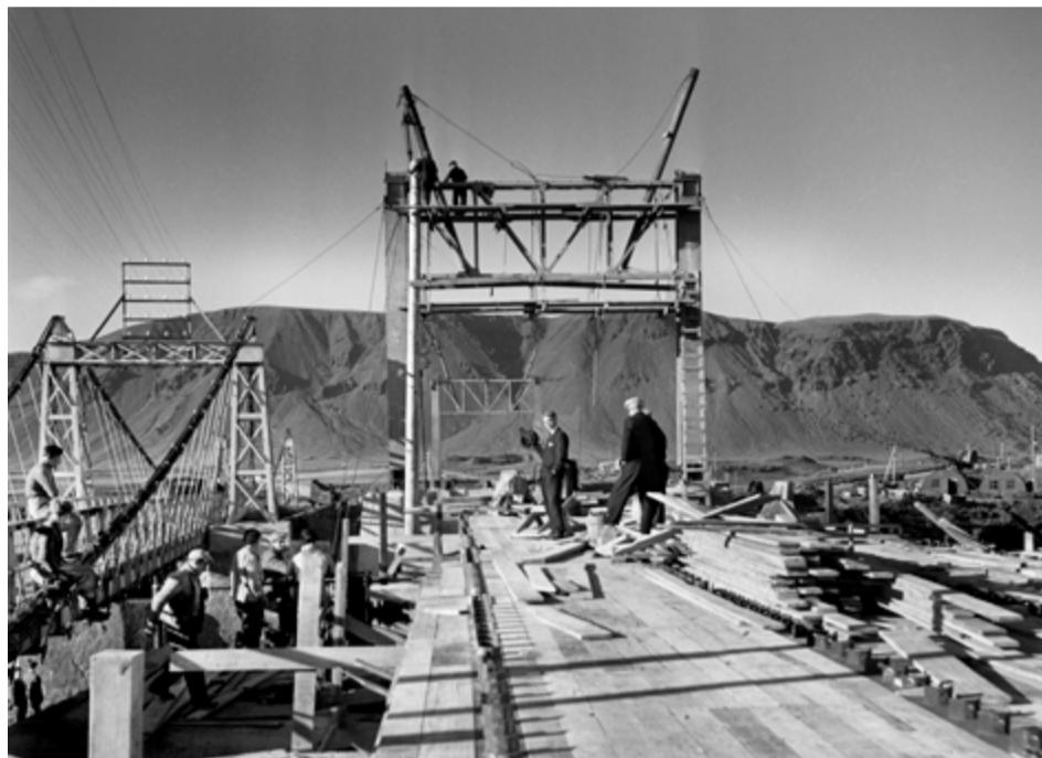
■ Ölfusárbrú II við Selfoss í smíðum 1945. Til vinstri sést gamla brúin.
