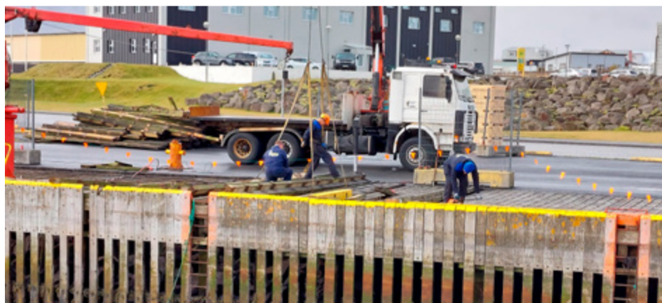
■ Unnið að lagfæringu Kvíabryggju, skipt um dekk og fleira.
