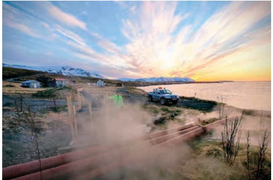
■ Framkvæmdir á vinnslusvæði hitaveitu við Ytri-Haga.
