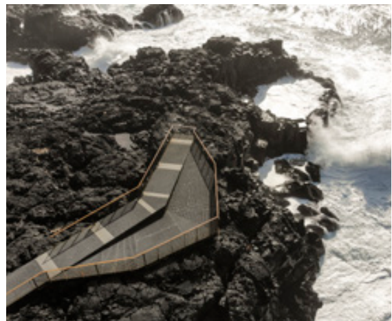
Fyrirtækið hefur komið að ýmsum verkefnum á Reykjanesi og byggði m.a. útsýnispallinn við Brimketil.
