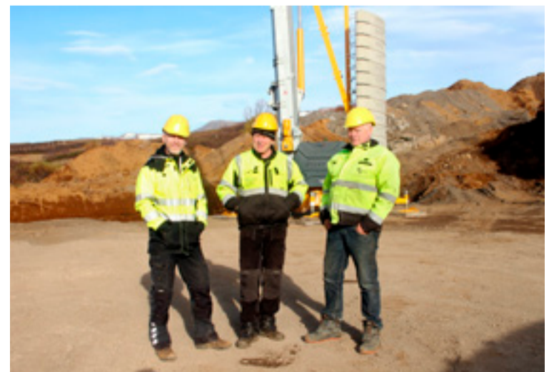
■ Feðgarnir Skírnir Sigurbjörnsson og Sigurbjörn Skírnisson ásamt Valdimar Kristjánssyni, (t.h) verkstjóra hjá GV gröfum á Akureyri sem hefur annast jarðvinnu í virkjunarframkvæmdunum í Fnjóskadal. Þeir þremmingar eru hér við grunninn að væntanlegu stöðvarhúsi Hólsvirkjunar.
