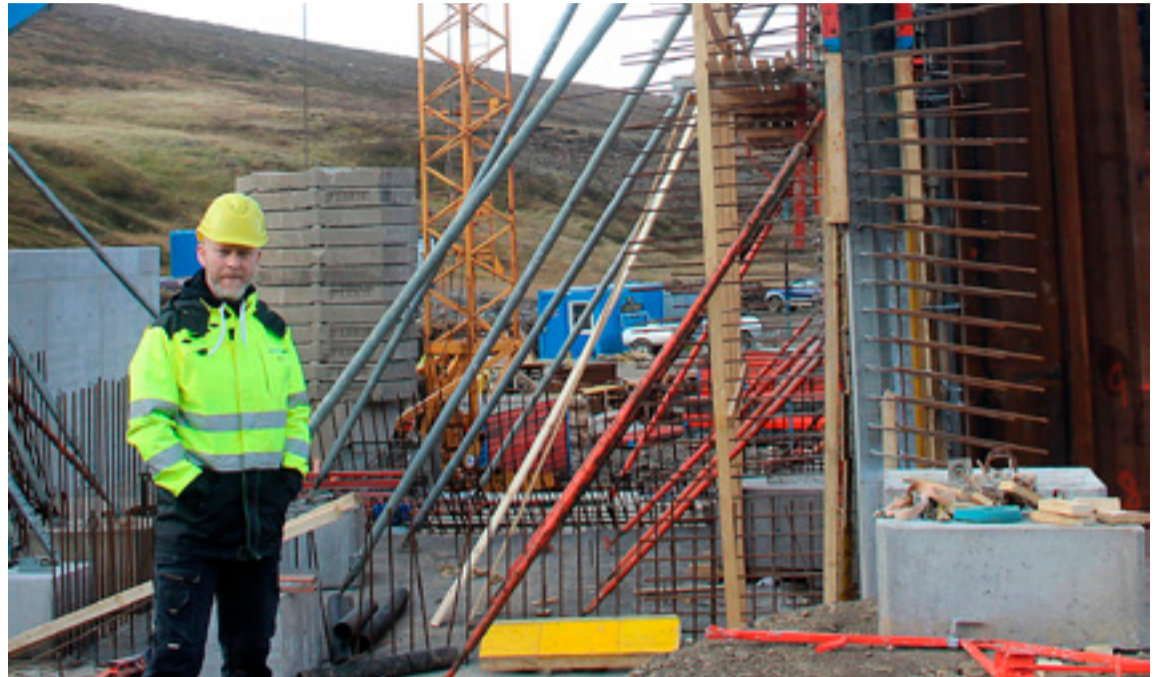
■ Skírnir Sigurbjörnsson, framkvæmdastjóri Arctic Hydro, við inntaksstífluna sem verið er að steypa í Hólsdal.
