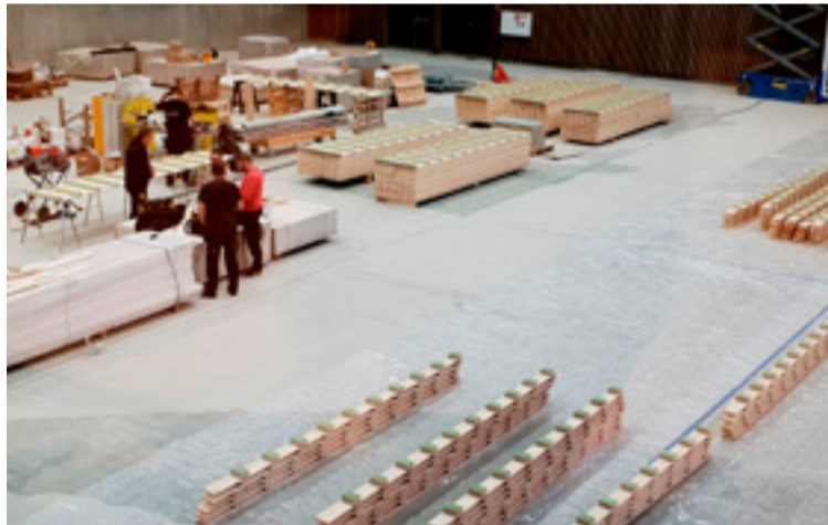
■ Nú er verið að undirbúa lagningu parkets á gólfíð í íþróttahúsinu.
