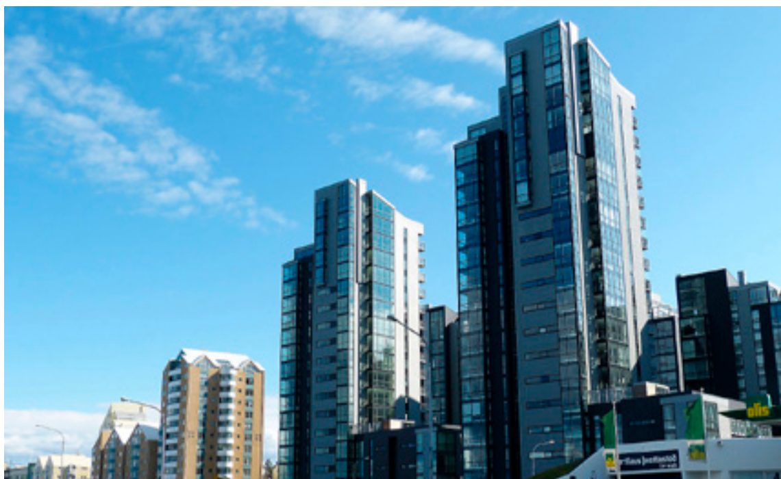
■ Viða eru að byggjast upp stór samfélög fjölbýlishúsa og huga þarf að flóknum rekstri þeirra í tíma.
