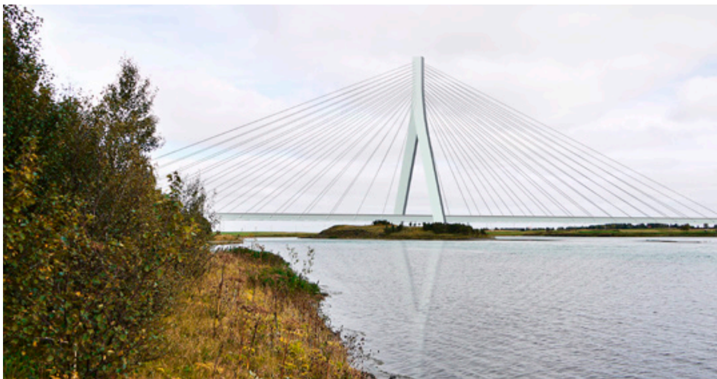
■ Fyrirhuguð brú yfir Ölfusá. Veggjöld verða notuð til að fjármagna stórar framkvæmdir eins og jarðgöng og brýr.
