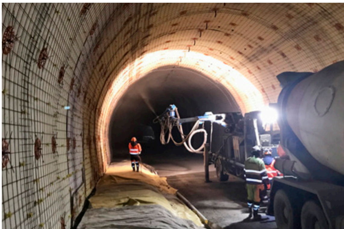
■ Unnið við vatnslæðningar í Dýrafjarðargöngum.
