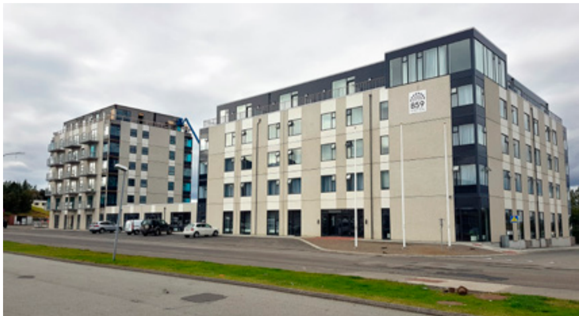
■ Hótél og íbúðarblokk í Borganesi sem er 5-7 hæðir, byggt er úr Smellinn einingum.
