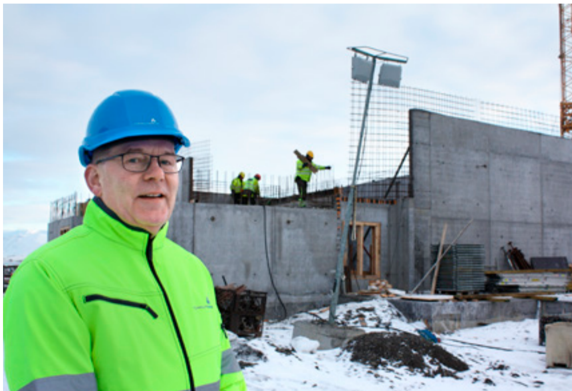
■ Helgi Jóhannesson, forstjóri Norðurorku, fylgist með byggingaframkvæmdum við nýja hreinsistöð í Sandgerðisbót.
