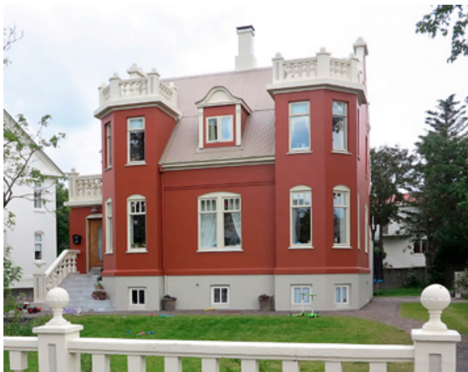
■ Sólvallogata 16. Teiknað fyrir A.J. Johnsons árið 1925. Húsið er afar sérstakt með sínum tveimur turnum og lífgar upp á umhverfi sitt.
