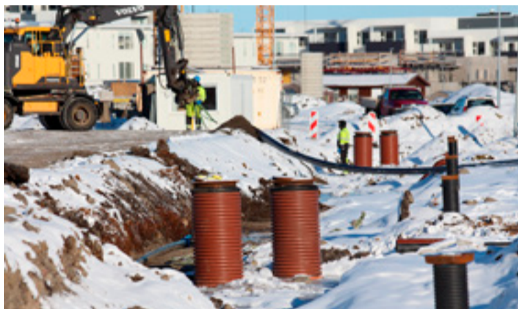
■ Byggingaframkvæmdir í Hagahverfi standa nú sem hæst.
