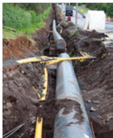
■ Haldið verður áfram að leggja Hjalteyrarlögn í sumar, hitaveit- lögn milli Akureyrar og Hjalteyrar í Hörgársveit. Þessi mynd var tekin þegar framkvæmdir stóðu sem hæst í fyrrasumar.
