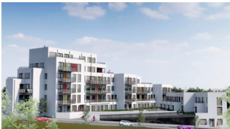
■ Við Trilluvog 1 eru framkvæmdir komnar vel á veg við byggingu fjölbýlishúss með 41 íbúð. Verklök eru áætluð um mitt ár 2019.
