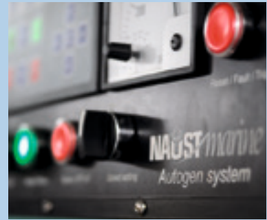
Управление лебедкой в панелях контроля
