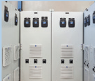
Управление лебедкой в панелях контроля
