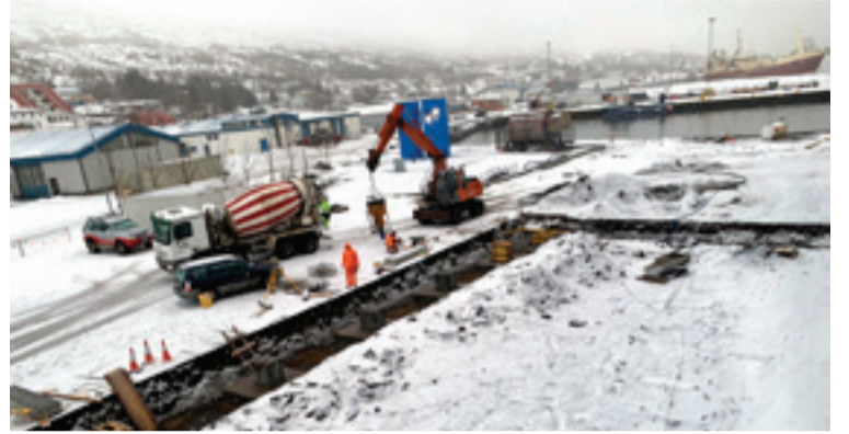
■ Á vormánuðum áformar Egersund Ísland að hafa lokið framkvæmdum við þvotta- og litunarstöðina en framkvæmdirnar kosta hátt í 300 milljónir króna. Þær koma til með að stórauka möguleika í þjónustu við fiskeldisfyrirtækin.
