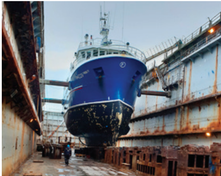
■ Togarinn Frosta ÞH var tekinn í flotkví í Hafnarfjarðarhöfn nú í febrúar til öxuldráttar og viðgerðar á stýri. Þorsteinn Harðarson skipstjóri vonast eftir að í maí verði skipið tilbúið til veiða á ný með nýja aðalvél, gír og nánast nýtt vélarrúm.
