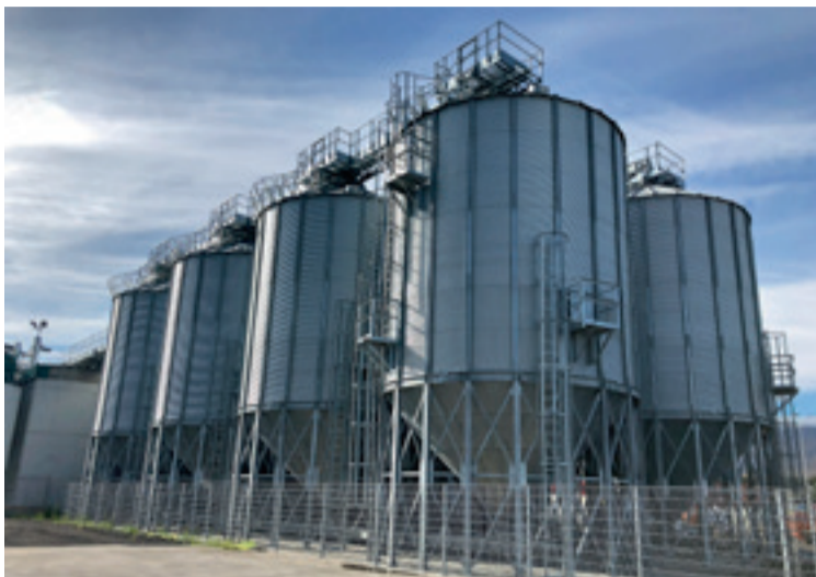
■ Nýju hráefnissílóin eru engin smásmíði. Þau eru 19 metra há og rúma samtals 2700 tonn af korni.
