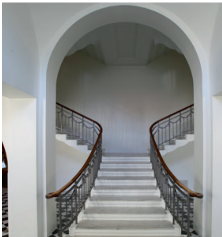
■ Form og fagurt handverk. Loft og stigar Safnahússins gerðir úr steinsteypu. Smíði hússins var alfarið í höndum íslenskra handverksmanna.
