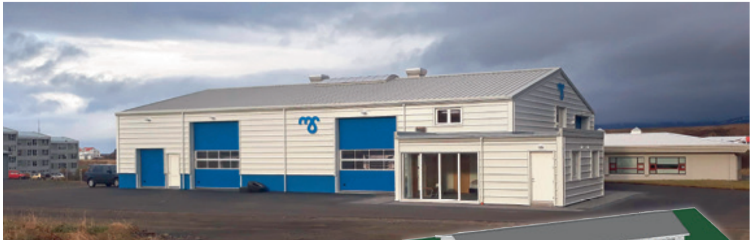
■ Á dögnum lauk Trésmiðjan Stígandi við byggingu 560 fermetra þjónustuhúss á Blönduósi sem byggt var fyrir Ámundarkinn ehf. en húsið verður leigt Mjólkursamsölunni.
