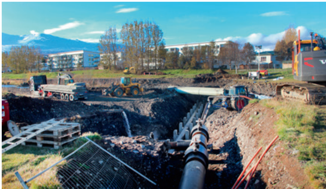
■ Síðustu vikur hefur verktaki við nýju stofnlögnina unnið að því að koma henni undir Glerá. Eins og sjá má var ánni veitt í rör yfir hyldjúpan skurðinn meðan lögninni er komið fyrir.
