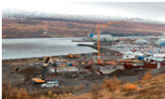
■ Fyrirtækið SS Byggir á Akureyri hefur með höndum byggingu nýju fráveituhreinsistöðvarinnar við Sandgerðisbót þar sem framkvæmdir eru komnar í fullan gang.
