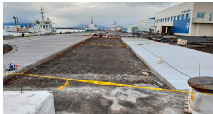
■ Miklar framkvæmdir hafa verið við höfnina á Rífi, stálþil endurnýjað og ný þekja steipt.
