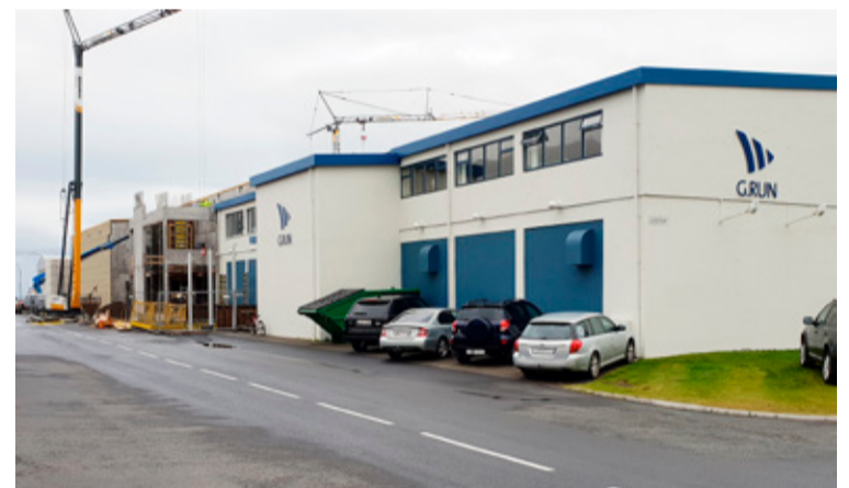
■ Framkvæmdir eins og þær stóðu fyrr í mánuðinum. Húsið komið upp og unnið að frágangi utan, sem innan.
